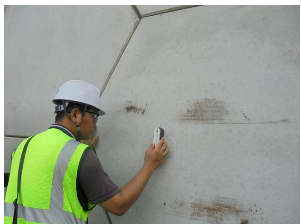
경사계를 이용한 경사도 측정
