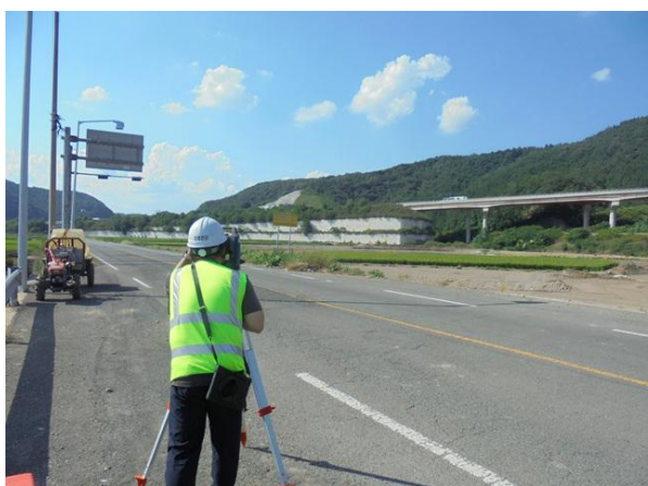
광파기를 이용한 측량 작업
